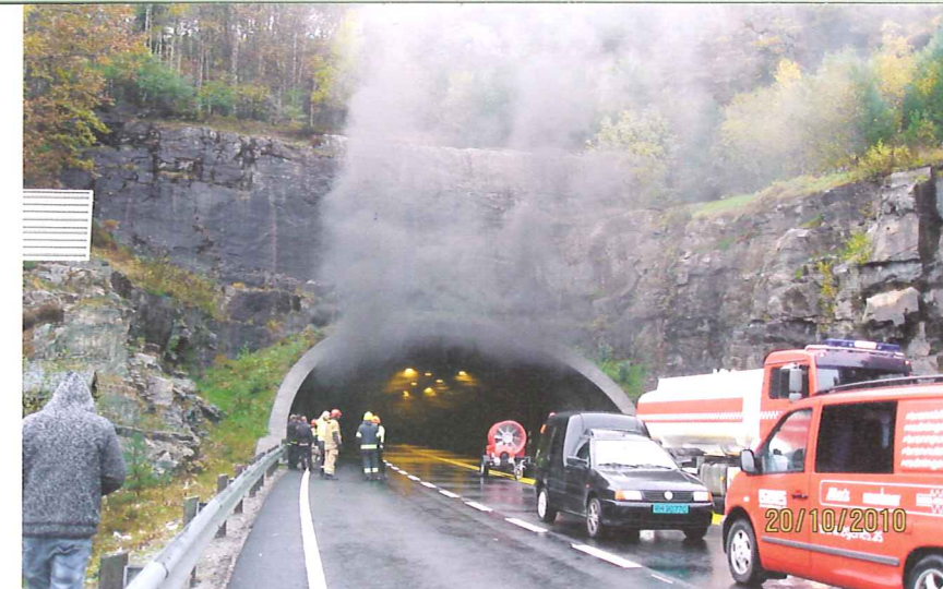
Røykutvikling på østsiden av Austadtunnelen for ventilasjon starter.
